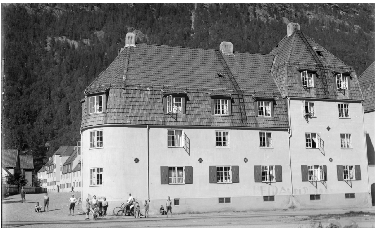
De 83 berømte Sing-Sing-boligene på Rjukan ble bygd i perioden 1915–17 av Norsk Hydro til arbeidere ved fabrikk. Boligene er lagt inn i en ganske massiv karrébebyggelse og inneholdt opprinnelig mye fellesfunksjoner som spiserom, vaskeri, badstue m.m. Dette er en byggeform som er kjent i samtiden fra andre steder i Norge og ikke minst mange andre land. Deler av bebyggelsen er senere blitt revet og resterende boliger organisert i et borettslag; forvaltet av Rjukan og Tinn boligbyggelag. Det er også blitt åpnet opp for at enkelte boliger i dag er fritidsboliger. Foto: Kristian Finkenhagen / Norsk Industriarbeidermuseum
