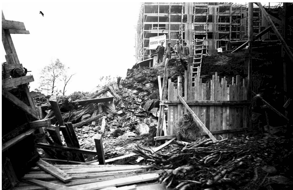
En sprengningsulykke fant sted under utbyggingen av Galgeberg 3 i 1935. Foto: Ukjent person, Oslo Museum
