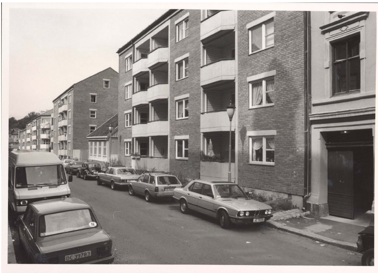
Korsgata borettslag var et byfornyelsesprosjekt på Grünerløkka i Oslo. Det består av to bygårder med til sammen 54 leiligheter og sto ferdig i 1986. Arkitekt: Truls Thorenfeldt AS. Foto: OBOS
