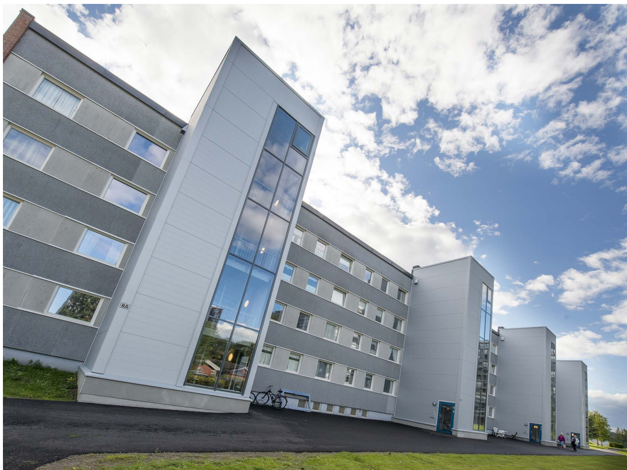
Mæla borettslag bygget 12 nye heiser på utsiden av eksisterende bygg i 2016. Heisene ga enklere atkomst til borettslagets 96 boenheter. Bilde fra NBBLs årsrapport 2016.
