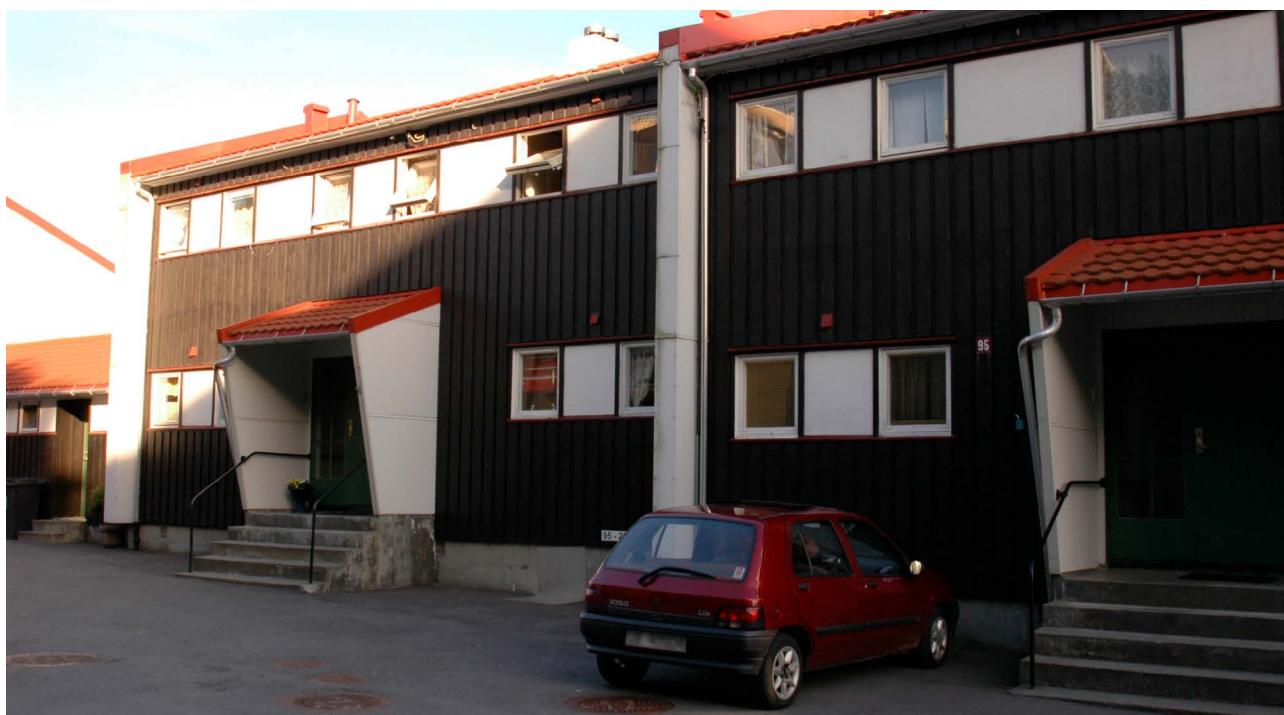
Borettslaget Storgata 89-95 i Kristiansund ble bygget av KBBL i 1965 og består av 16 leiligheter i firemannsboliger. Foto: NBBL
