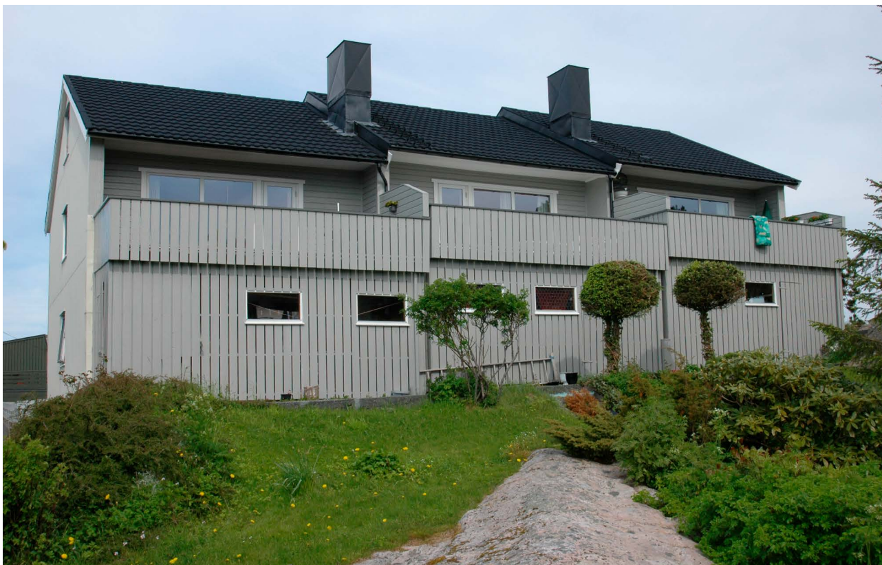
Fløya Terrasse borettslag ble bygget av Kristiansund Boligbyggelag i 1961 og består av seks rekkehus i et barnevennlig og solrikt område. Foto: NBBL 2008
