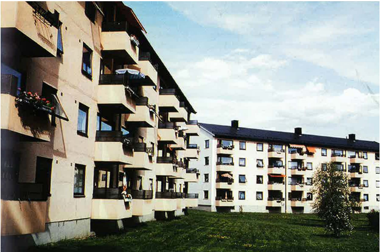
Fjellet borettslag med 148 boenheter i Lørenskog, nordøst for Oslo, sto ferdig dette året – det klart største borettslaget Lørenskog BBL hadde utviklet til da. I årene som følger er imidlertid laget byggherre for flere lignende boligprosjekter. Lørenskog kommune er på dette tidspunktet preget av meget sterk befolkningsvekst, noe som også er tilfelle i de seneste årene før og etter 2020 (3–4 prosent årlig vekst). Foto: Lørenskog BBL
