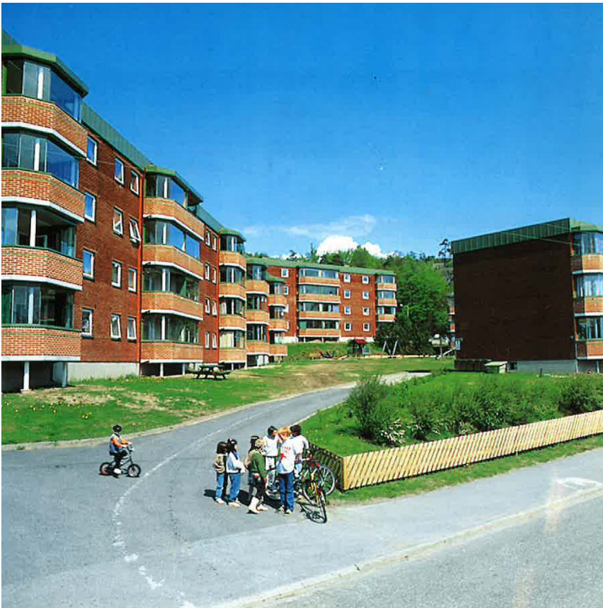
Kilden borettslag, bygget av Larvik Boligbyggelag i 1968. Foto: LABO
