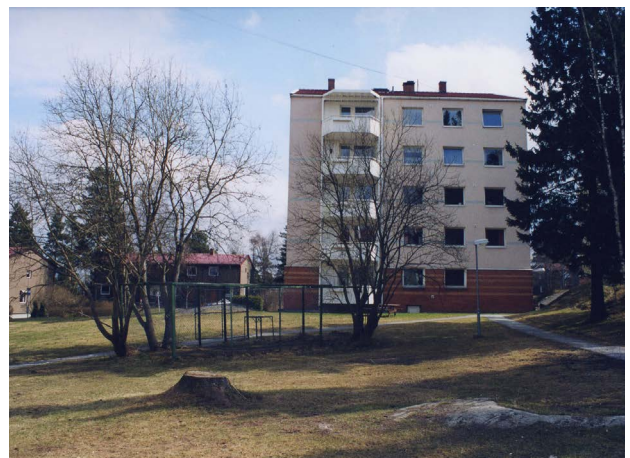
OBOS-borettslaget Marmorberget på Lambertseter i Oslo.
