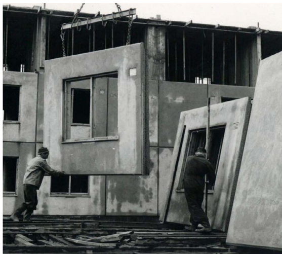
På 50- og 60-tallet ble Usbl en pionér innen industriell boligbygging. De ble tildelt et stort kommunalt tomteareal på Årvoll som skulle bebygges med blokker. Det ble starten på en storstilt satsing hvor Usbl tok spranget fra håndverkerbasert byggevirksomhet til montasjebygging med kraner og prefabrikkerte elementer, produsert i egen fabrikk på Skedsmo. Foto: Usbl
