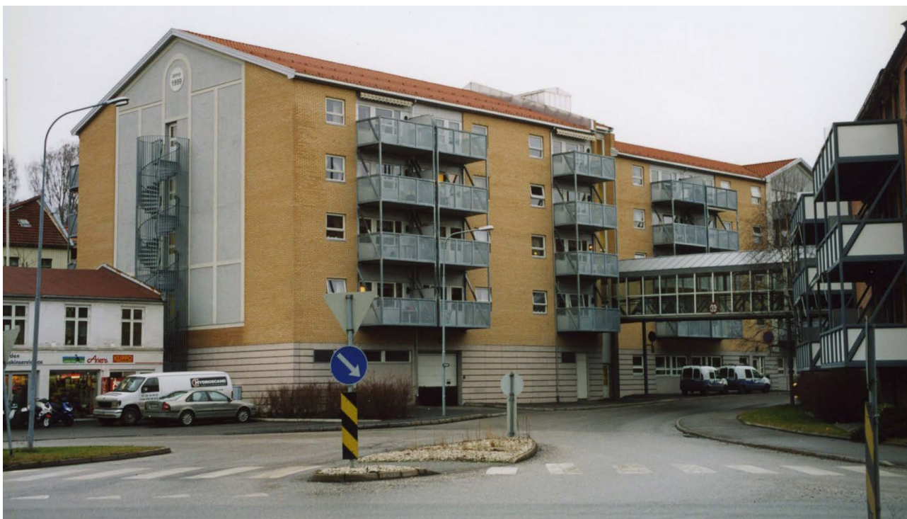
Hagegata borettslag består av 57 leiligheter og sto ferdig i 1999. Foto: Halden boligbyggelag (HABO)
