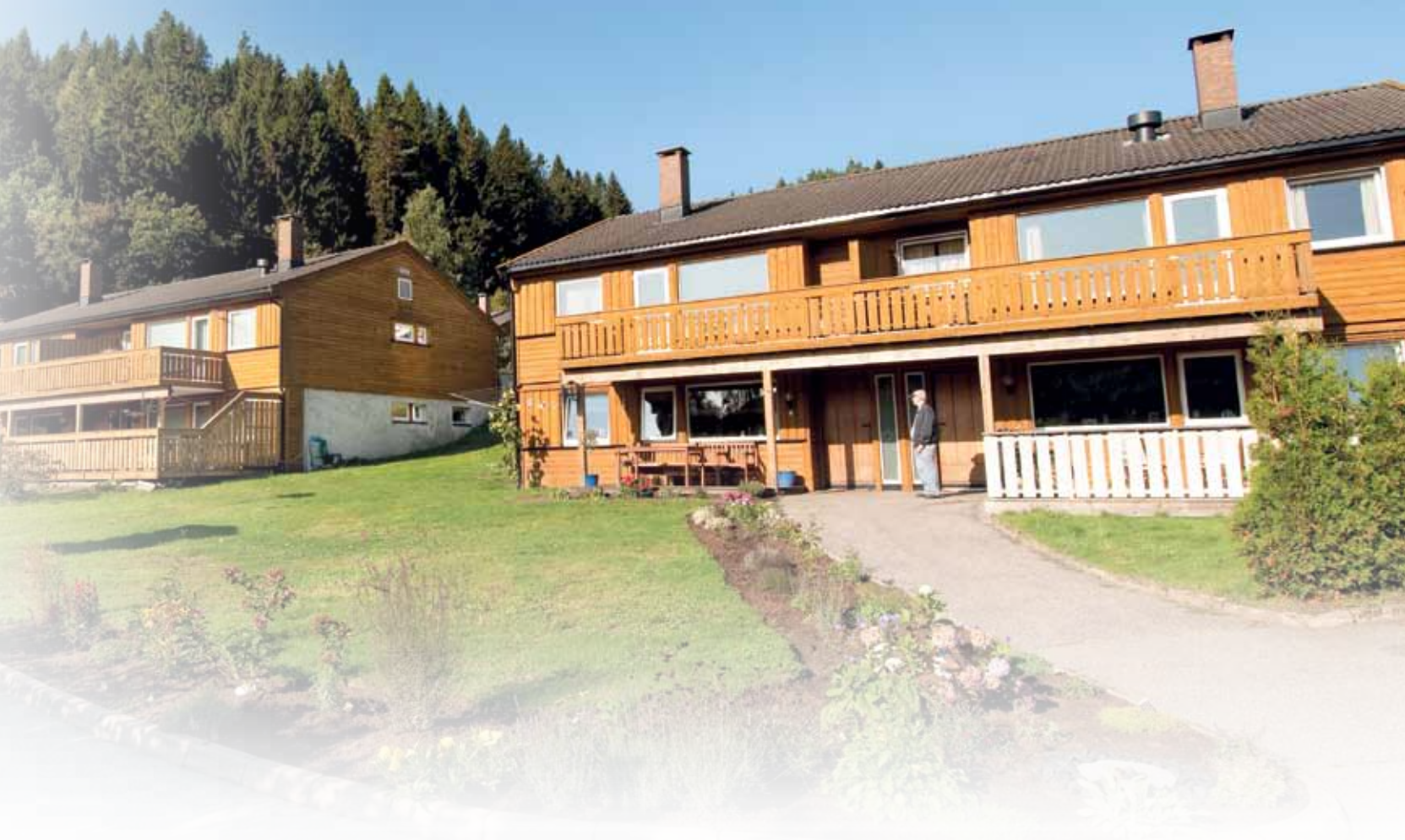
Wergelandstunet Borettslag på Mosby i Kristiansand fikk Sørlandet Boligbyggelags miljøpris for å ha rehabilitert de 28 boenhetene til lavenergiboliger. Foto: Kjell-Inge Søreide
