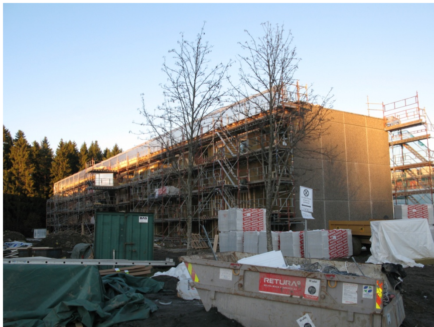
Myhrerenga borettslag under oppgradering. Foto: SINTEF Byggforsk.
