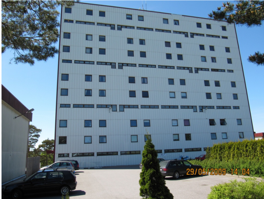
Gullveien borettslag pr. 2010, høyblokk. Foto: Boligbyggelaget.
