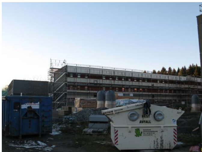
Myhrerenga borettslag under oppgradering. Foto: SINTEF Byggforsk.
