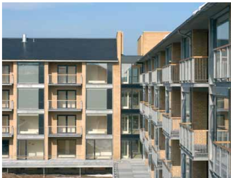
Motalavej kvarteret i Korsør Danmark. En ombygning af 60 familieboliger til 61 ældreboliger med tilhørende serviceareal på ca. 600 m 2 , som led i gennemførelse af en Helhedsplan for et område på knap 1000 boliger. Ombygningen er blandt andet sket for at skabe større bredde i udbuddet af boliger, og for at opfylde et behov for boliger med bedre tilgængelighed i bydelen. Foto: KAB - Bolig og Byggeadministration
